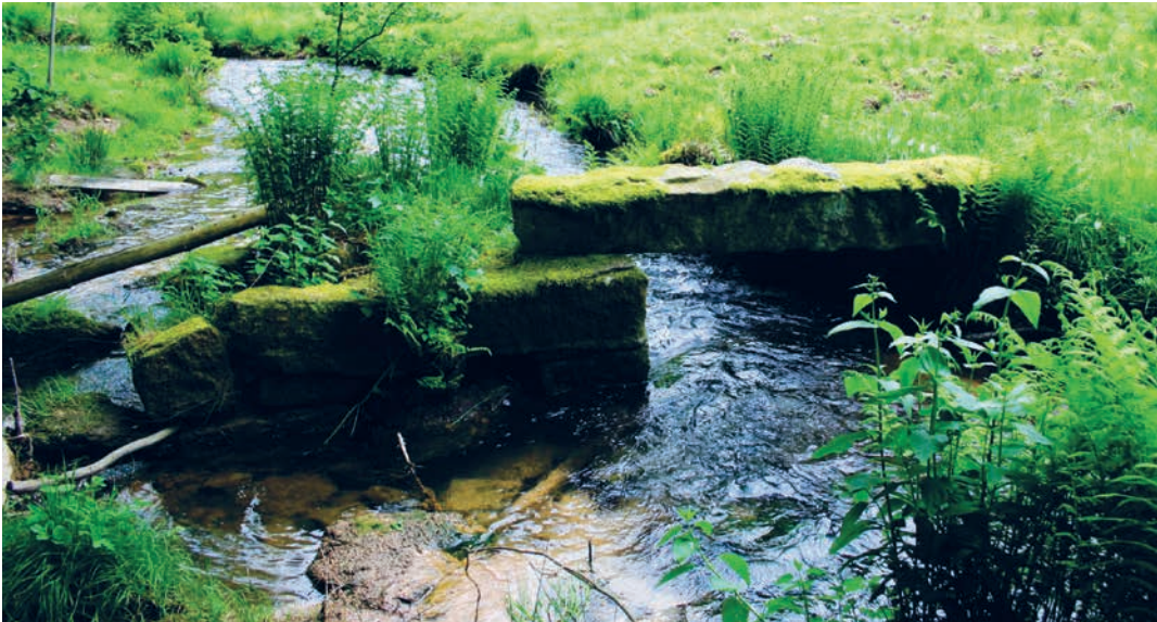
Wehranlage in der Hafenlohr
